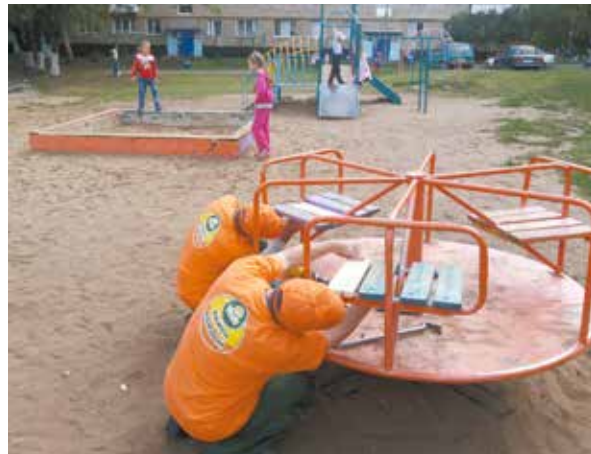
Ремонт качелей и каруселей на детских площадках Сидоровка С-16, С-1, Сидоровка С-30а.
