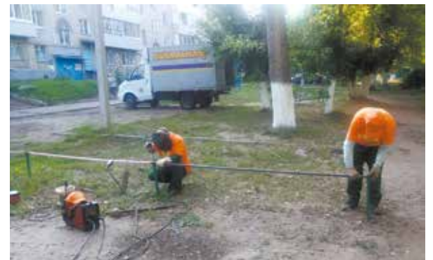
Установка ограждения на детской игровой площадке Сидоровка С-14.
