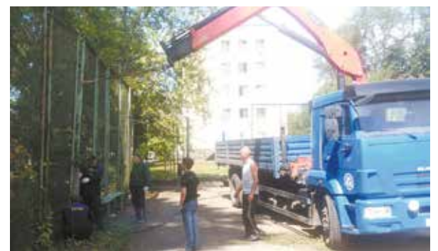
Ремонт баскетбольных колец на детской спортивной площадке Сидоровка С-16.
